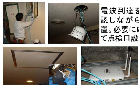
電波到達を確認しながら設置。必要に応じて点検口設置
